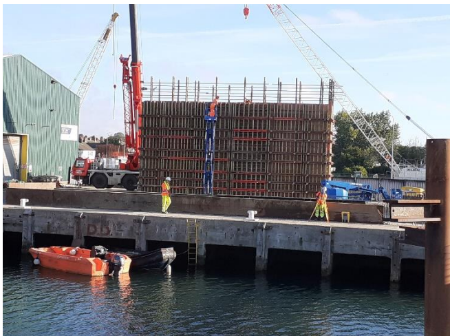
A – Pier 6 Shuttering for Concrete Pour
