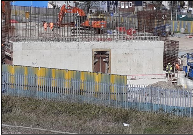
A - North Abutment Concrete Pour
