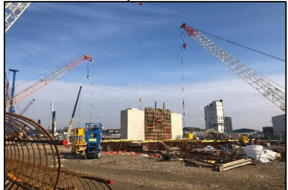
D - Pier 3 – Pour Complete
