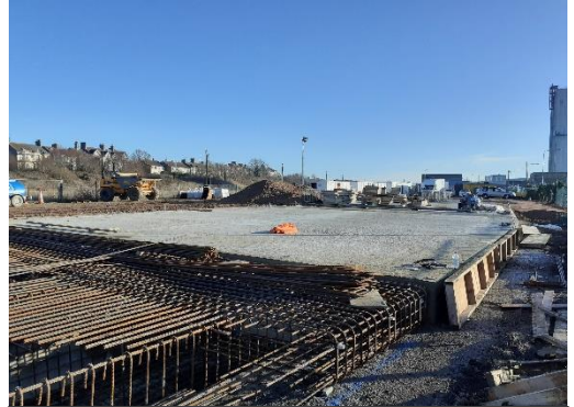
NAV 1 Concrete Pour
