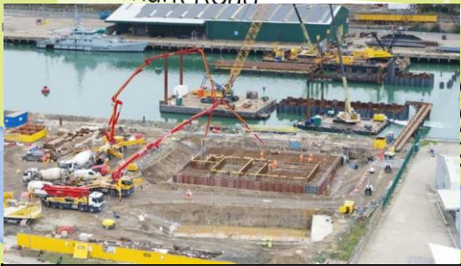
Pier 3 – Concrete Pour
